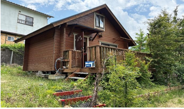
北東側より撮影
