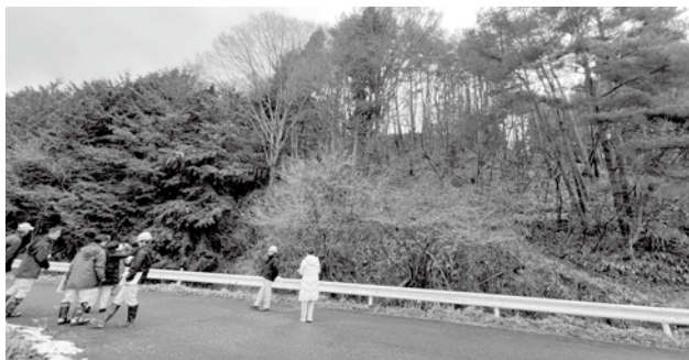
新トンネル坑口
