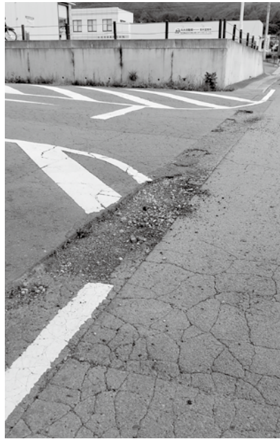
舗装が待たれるグランド駐車場入口
