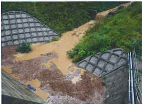
上流で発生した土石流の捕捉状況 (本堤天端より上流側を撮影 H25.9.17)
