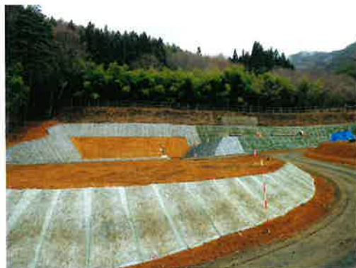
市之沢浄水場造成
