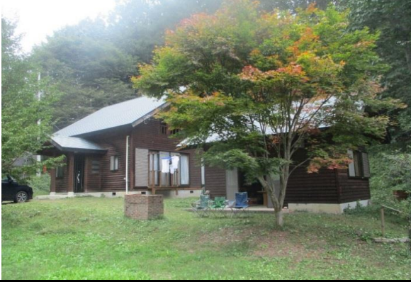
外観、手前作業所
