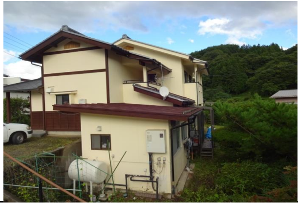
外部北西より
