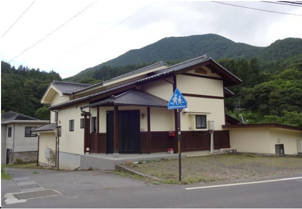
外部北側より
