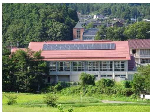
屋内運動場の屋根に設置された太陽光発電設備（左：青木小学校 右：青木中学校）
