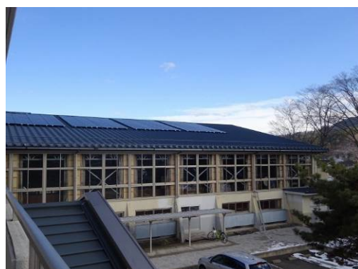
屋内運動場の屋根に設置された太陽光発電設備（左：青木小学校 右：青木中学校）
