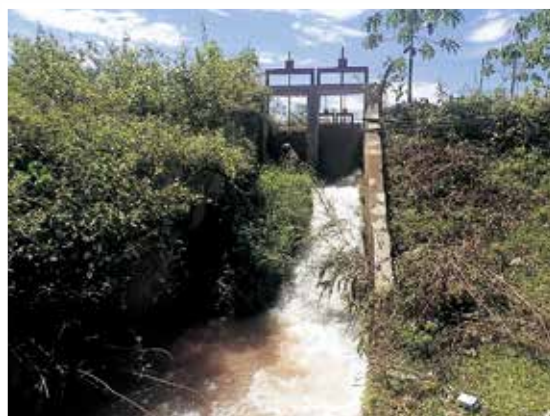
シェンクアン県「ミライズあおき」設置予定水路堰
