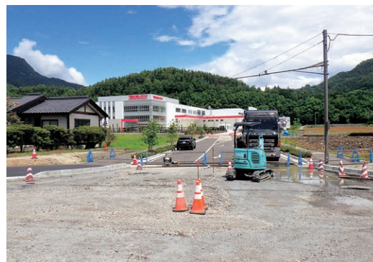
国道工事の完了に併せて、 村道との交差点も開放いたします。
