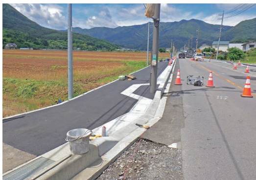
アスファルトの舗装工事が始まりました。
