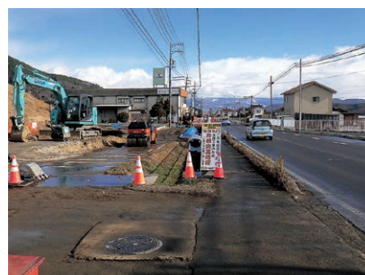
1. 国道143号改良工事
