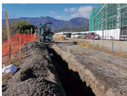
4. 配水管布設工事
