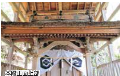
本殿正面上部
