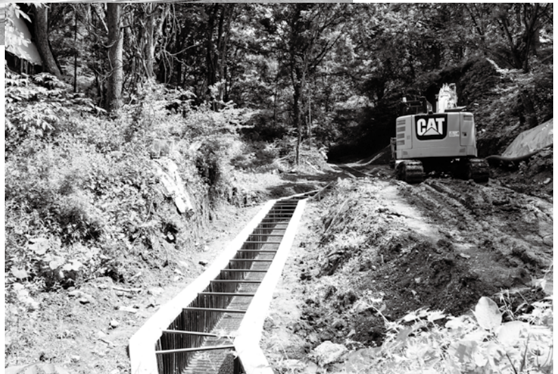
琴山川整備工事
