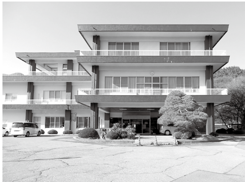
築40年以上経過した文化会館
