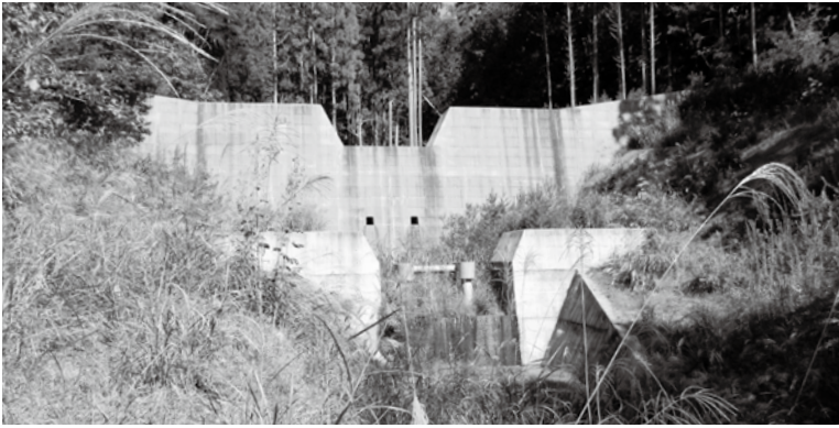
平成24年に入田沢洞中之組沢に設けられた長野県設置の砂防堰堤
