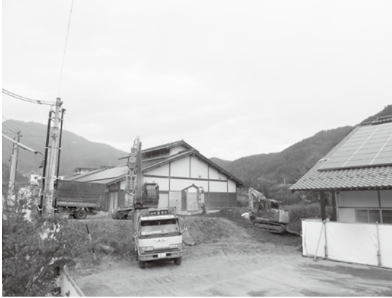
建設に着工した五島慶太未来創造館
