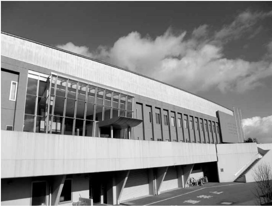
役場庁舎・保健センター
