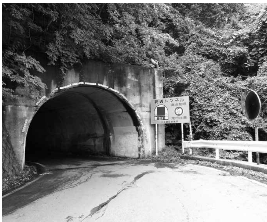
大型車が通行できない現在の青木峠「明通トンネル」
