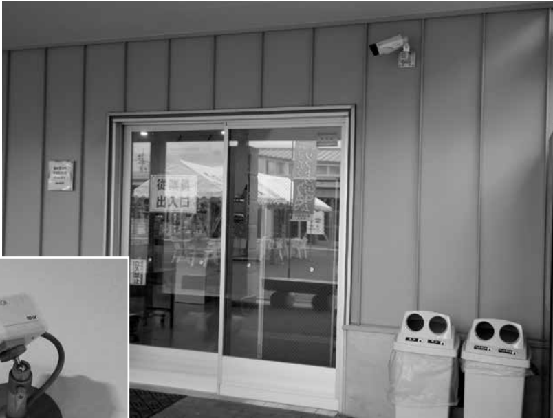
農産物直売所入口に設置されている防犯カメラ
