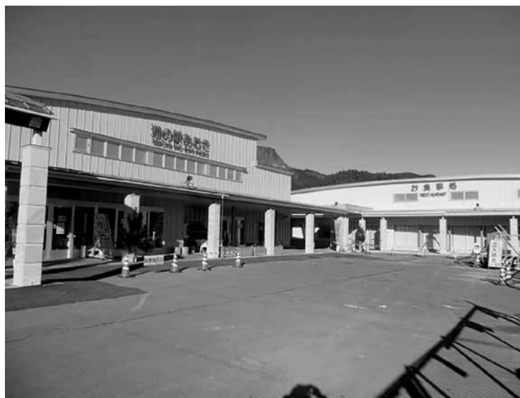
改修が進められている 道の駅あおき
