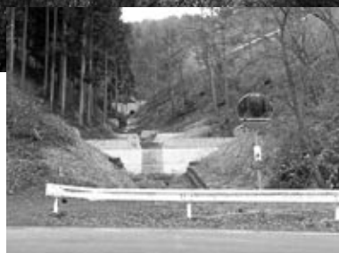
道路に面した各沢の堰堤
