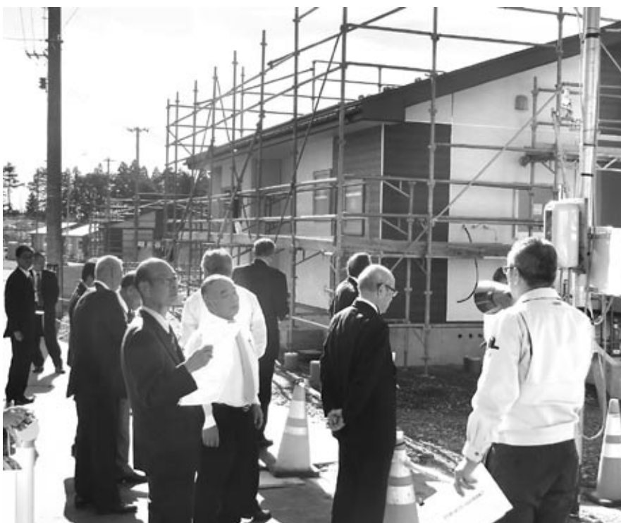
高台移転にともなう建築現場
