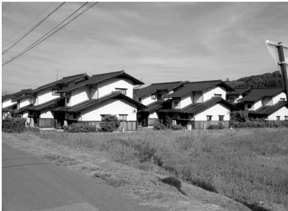
青木村村営住宅
