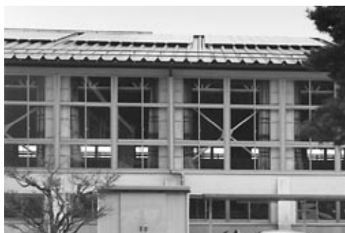
青木中学校に設置された太陽光発電システム
