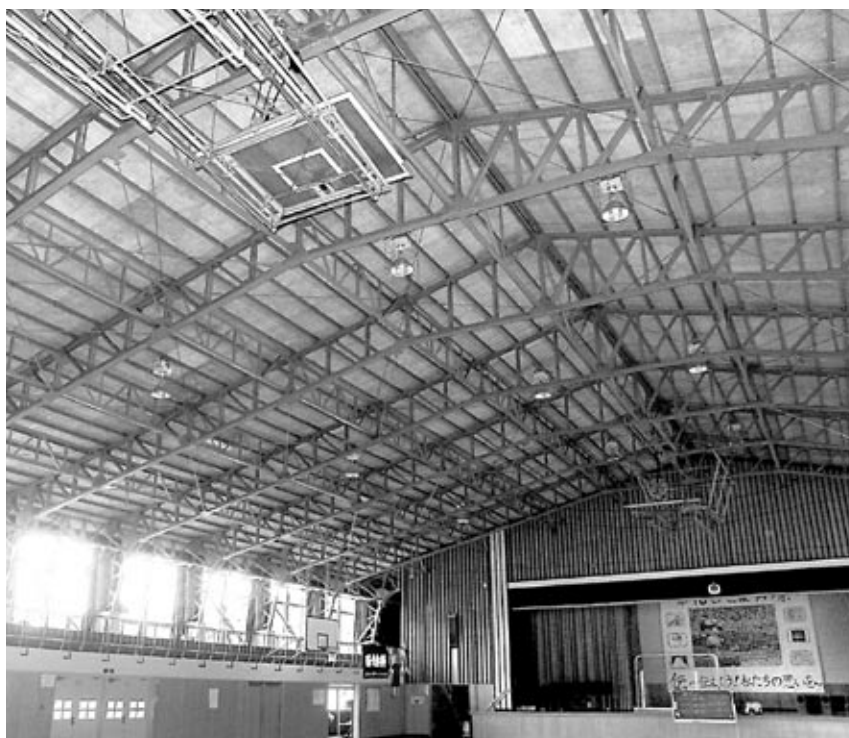
耐震補強工事が済んだ青木中学校の体育館
