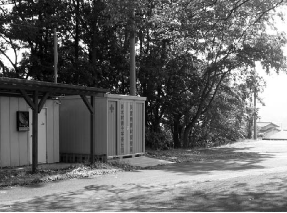
日赤奉仕団の災害用資材保管庫
