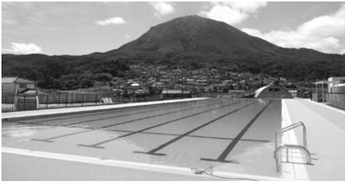
改修された村営プール
