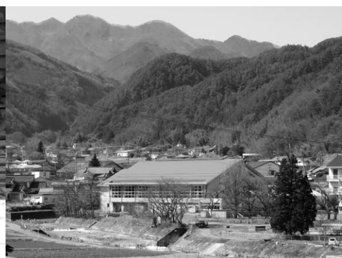
小学校体育館屋根への太陽光パネル設置
