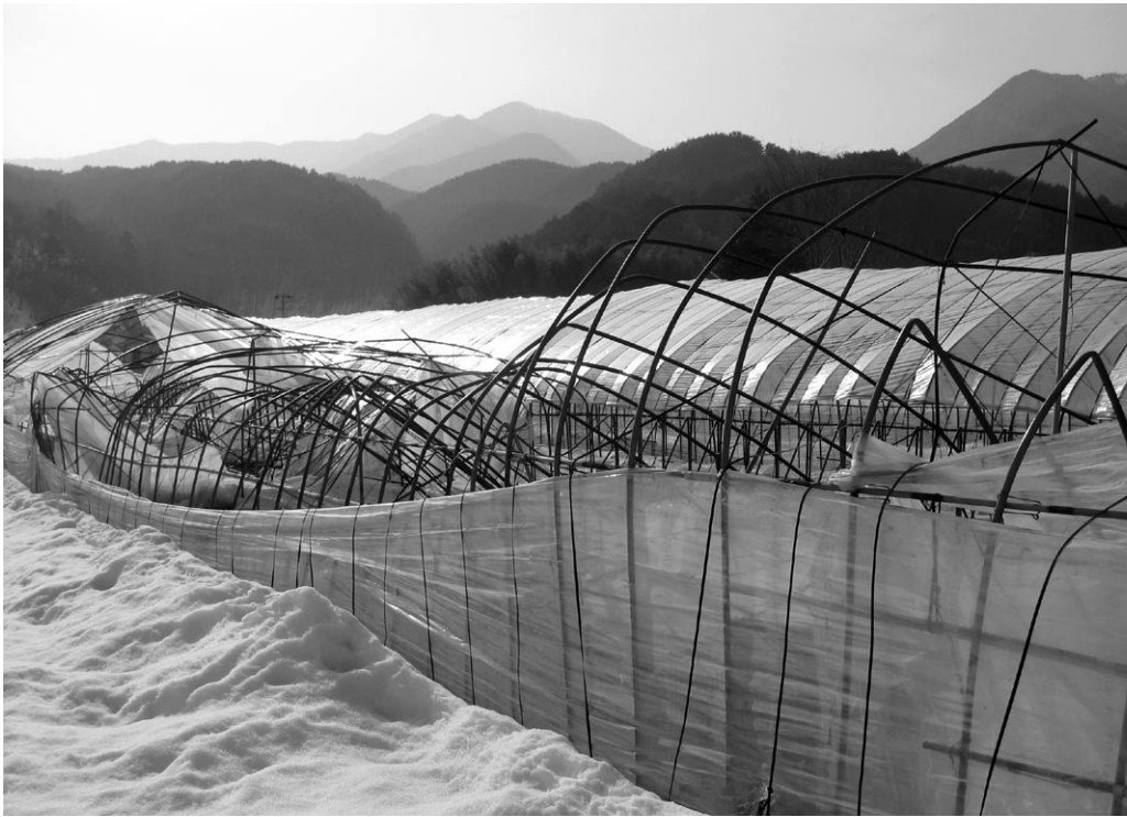
雪害で倒壊したビニールハウス
