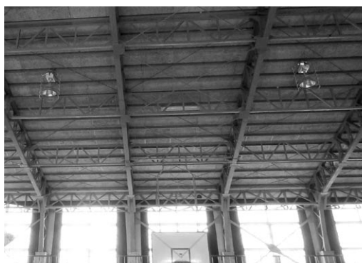
中学校体育館改修
