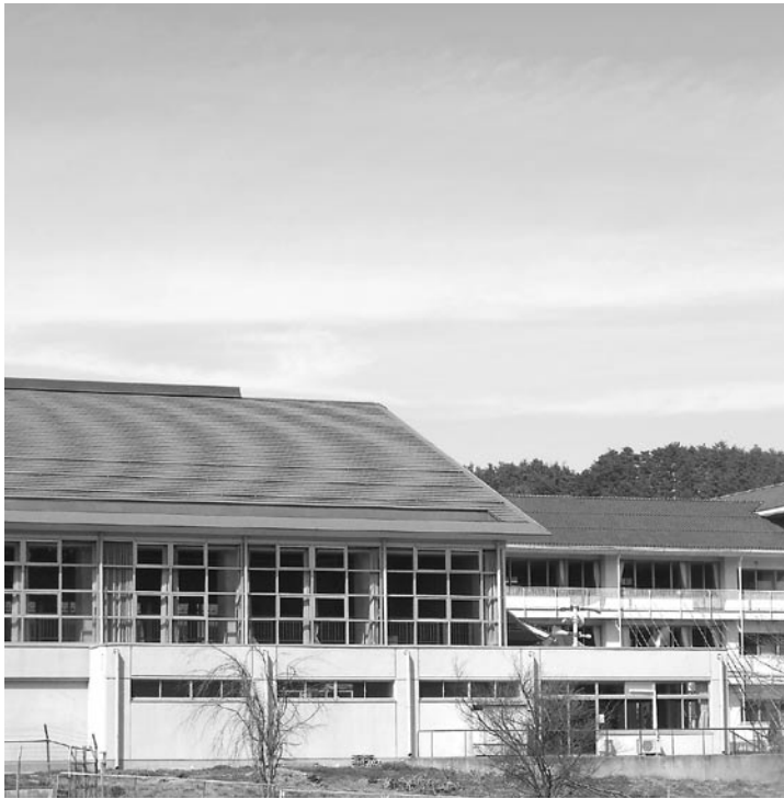
小学校体育館屋根に太陽光発電を
