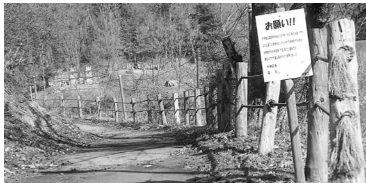
中挟・太子公園歩道手すり
