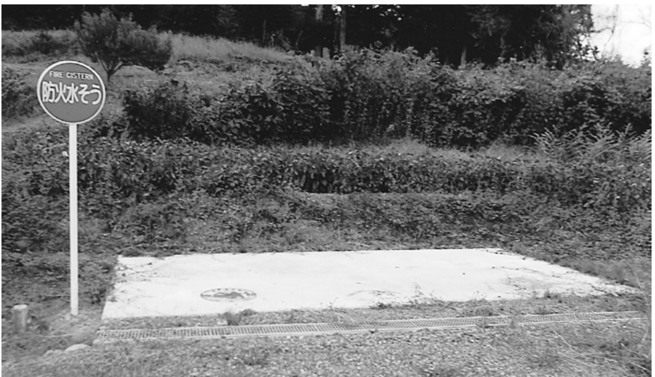
新設地下式防火水槽
