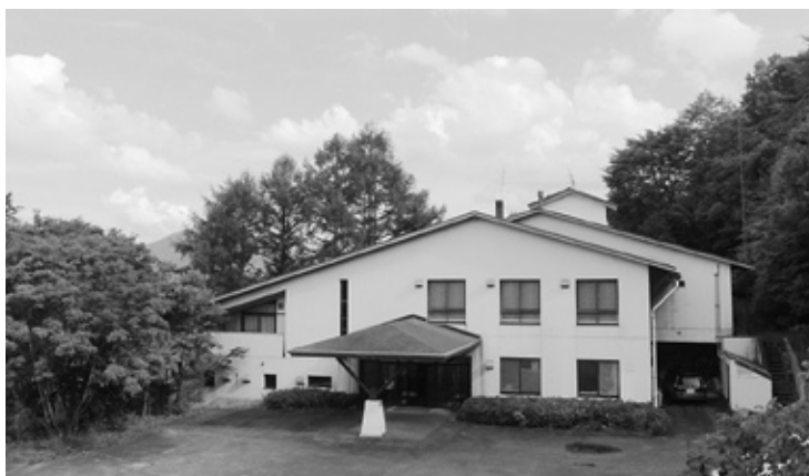
屋根の改修を予定している信州昆虫資料館
