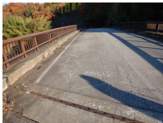
健全度 II : 山岸橋
