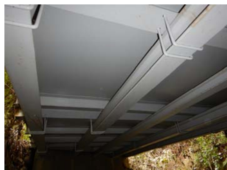
写真2. 床板補修例 炭鉱3号橋 (錆止剤塗布)
