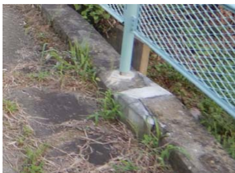
写真1. 地覆修繕例 大法寺橋 (部分補修)
