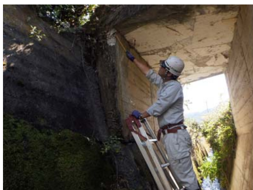
写真 1. 梯子による点検
