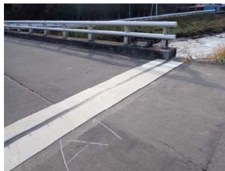
写真4. 伸縮装置補修例 殿戸橋 (伸縮装置更新)
