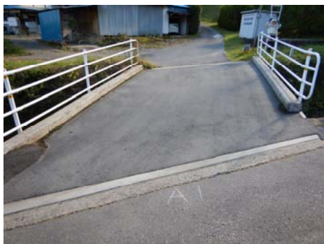
写真3. 橋面補修例 向山2号橋 (舗装更新)
