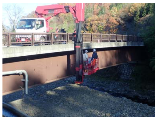
写真 2. 橋梁点検車による点検
